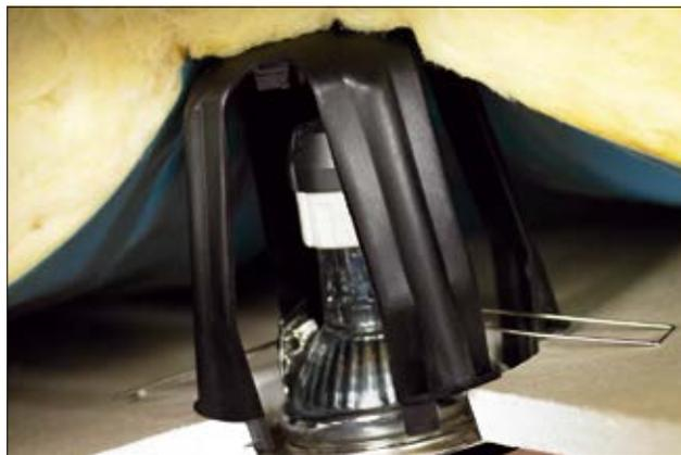
SpotClip-I ermöglicht eine sichere und verlässliche Leuchteninstallation.
