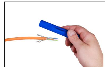
6. Folienschirm durch Drehung anschneiden und händisch entfernen
