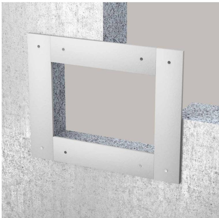
**Abb. 10:** Aufleistung für Massivwand oder leichte Trennwand
