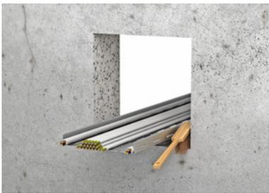
2. Bei Wänden muss mittig der Laibung oben und an den beiden Seiten der 50 mm breite intumeszierende Streifen Kerafix Flexpan 200 NG-A aufgeklebt werden. Bei Decken muss der Streifen in der Decke bündig mit der Deckenunterkante rundherum an der Laibung eingeklebt werden. Nach Möglichkeit die erste Lage Kissen unter dem Kabelbündel bzw. der Kabelpritsche platzieren.
