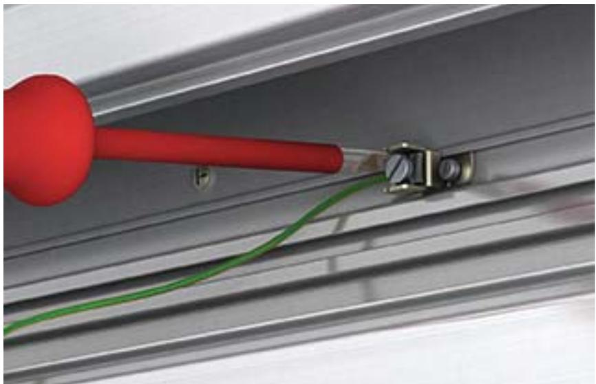
**Bild 52** Schutzleiteranschlusswinkel im GA Kanal
