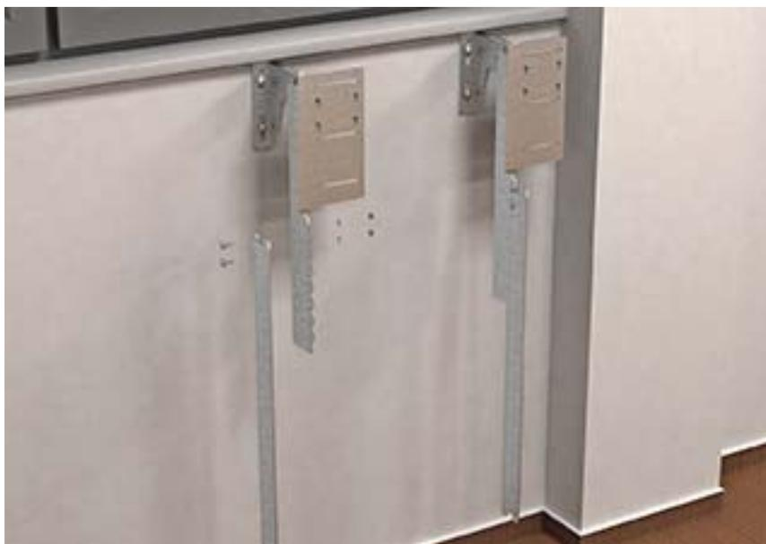
**Bild 10** Montage- und Verbindungsprofil auf Wandkonsole
