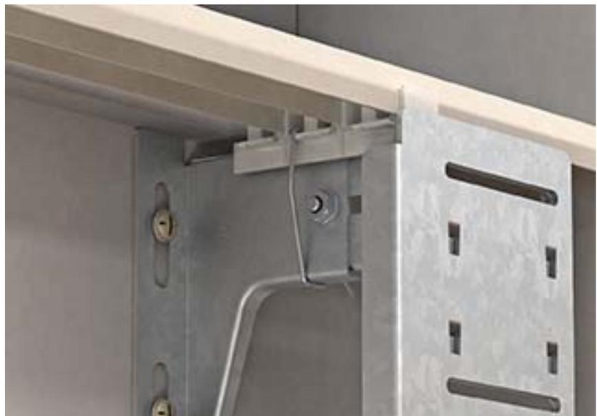
**Bild 7** Wandkonsole mit fertig montierten Konvektionsgitterprofilen
