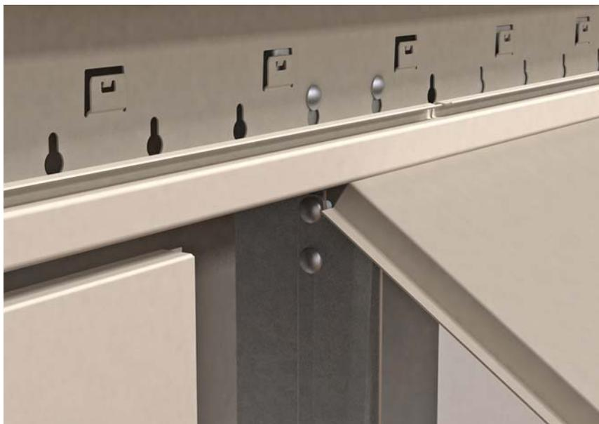
**Bild 11** Einhängen der Konvektorverkleidung auf dem Montageschwert
