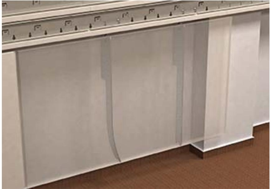
**Bild 12** *Verdeckte Befestigung des Panels*
